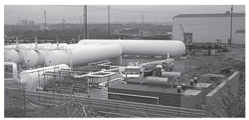
Рис. 6.1. Смесительная система производства Algas-SDI и парк хранения СУГ, используемые для газоснабжения населенного пункта в США. Установка производит 21 тыс.  $\rm m^3/4$  синтетического натурального газа,  $\rm P_{\rm shx}$ . — 0,055 МПа
