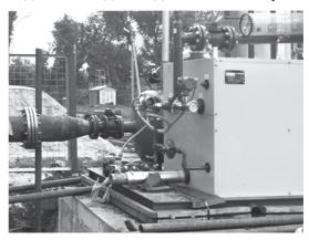
Рис. 6.2. Город Красный Сулин, центральная городская котельная мощностью 19,3 МВт. Монтаж испарительно-смесительной установки Metan-3-2-760 производства завода «Газ-Сервис» в качестве источника резервного газоснабжения
